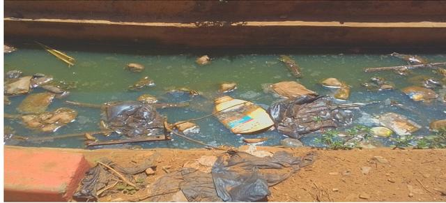
A la sortie, c'est un caniveau long de plus de 5km à ciel ouvert situé à lowo dans l'arrondissement de Savalou-Aga. Ce caniveau regorge des déchets de toutes sortes qui obstruent l'écoulement de l'eau et entraînent par conséquent la prolifération des moustiques vecteurs du paludisme. Ce malveillant constat remet au centre la question de l'abonnement aux structures de collecte de déchet. Les risques sanitaires sont relativement liés à l'insalubrité ambiante qui caractérise la ville de Savalou.
