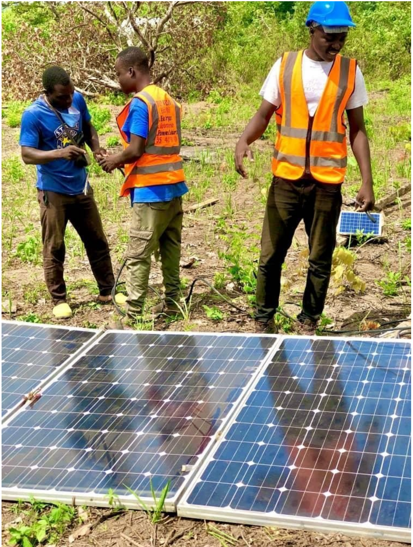
Installation de panneaux solaires
